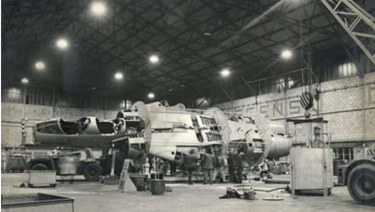
Essai de " barattage " du fuselage du Mirage G8-01, avant remontage complet de la cellule
