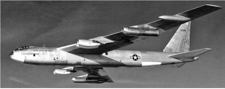
Boeing XB-52 P&W montrant un unique moteur P&W J75 installé en position extérieure pour évaluation en vols de l'augmentation de la poussée globale installée. Photo crédit internet.
