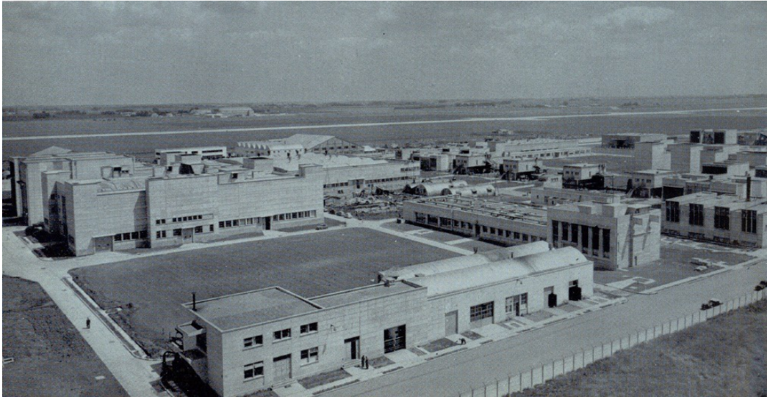
Installations d'essais à Melun-Villaroche
