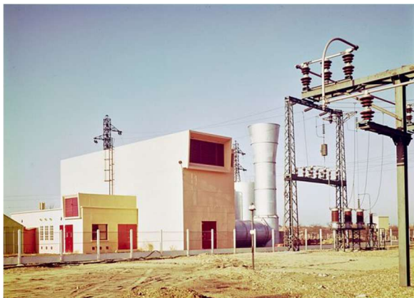
EDF à Villemendeur (@ Espace Patrimoine Safran)
