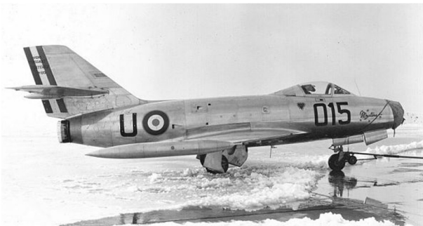
MD-452 Mystère II-015 codé U équipé du déviateur de jet. (© Espace Patrimoine Safran). Le Mystère II n° 015 sert spécialement pour l'étude des déviateurs de jet de 1955 jusqu'en 1957.
