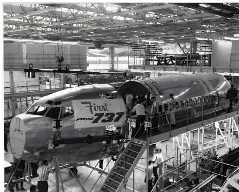
Premier Boeing 737-100 en cours d'assemblage sur la chaîne de montage dans l'usine historique "Le Plant 2" situé le long de Marginal Way à Seattle. Les moteurs étaient des JT8D déjà en service sur le Boeing 727 et le Douglas DC9.
