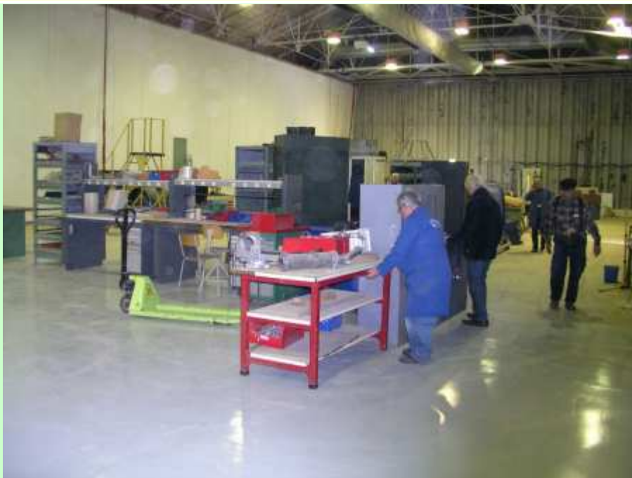
Installation en cours des postes de travail "montage-démontage" moteurs (novembre 2013)
