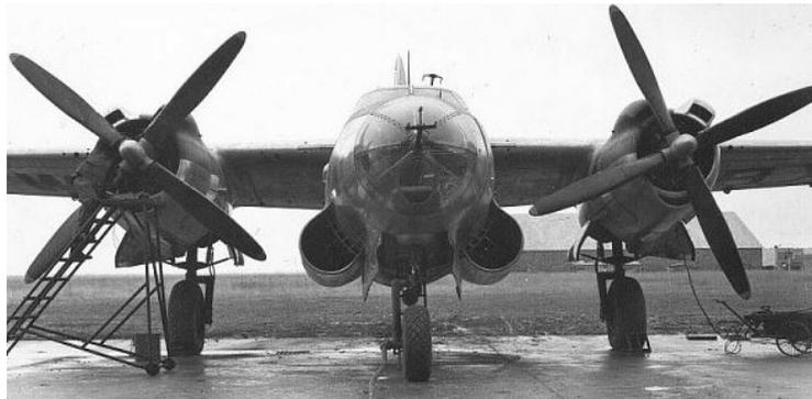
Le Glenn Martin B-26 G-11 "Marauder" serial 43-34584 modifié avec ses entrées d'air en sifflet, banc volant de l'ATAR 101 AO n° 1001 (1950). Immatriculé F-WBXM jusqu'au 19 juin 1951 puis F-ZVLA jusqu'en mai 1958.
