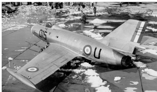
Mystère II-015 équipé du dispositif de déviation de jet (@ Snecma)
