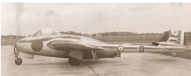
DH 100 Vampire équipé du dispositif de déviation de jet (@ Snecma)
