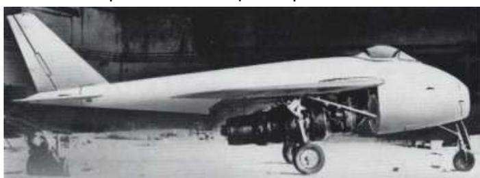
Messerschmitt P1101 prototype en cours de travaux équipé d'un réacteur Heinkel He-S11. Cette photo a été prise sur le site de l'avionneur à Oberammergau au début de l'année 1945. Ce prototype non achevé n'a jamais volé. Photo crédit archives de la Luftwaffe.
