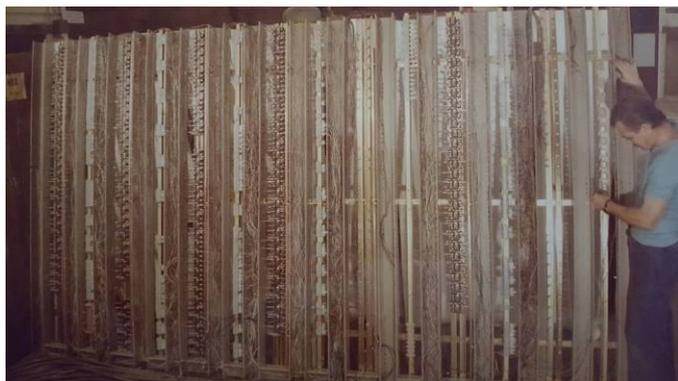
Bornier " raccordement mesures " RAM (partiel)
