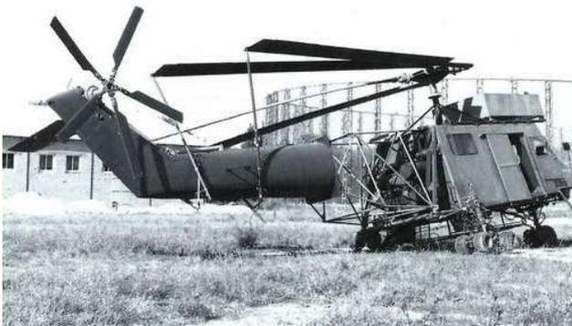
Maquette roulante, à l'échelle 1, surnommée "Belphégor". La photo est prise devant "la cage aux lions" de Marignane dans laquelle les turbomoteurs et la chaîne dynamique subissent de sévères contraintes d'endurance (1966)
